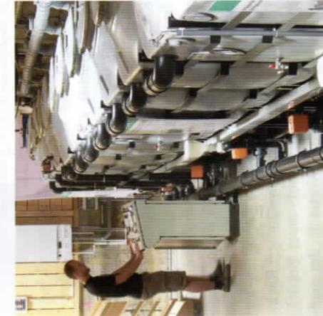
Bild 3 Blick auf die mehrstufige Grauwasser- recyclinganlage im Block 6      Quelle: Nolde & Partner
