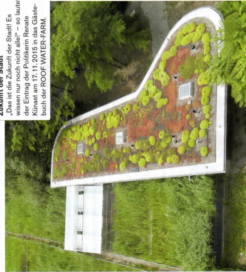
Bild 1 Blick auf das „Wasserhaus“ im Block 6 von ROOF WATER-FARM mit Grauwasserrecycling- und eine Schwarzwasseranlage, Betriebs- und Goldwasser werden im angrenzenden Gewächshaus getestet.
